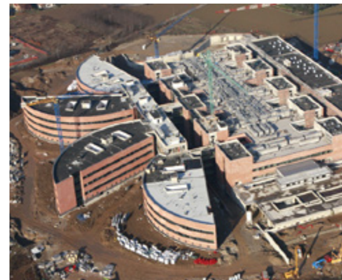
Bau von 16.000 m 2 Einrüstung in 6 Monaten
