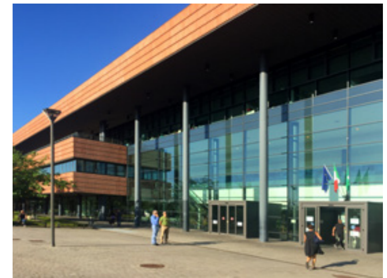
Stützen PDTI® NPS® mit 12 m Höhe und einem Durchmesser von 60 cm
