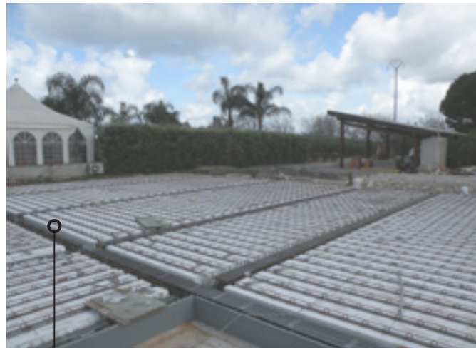
• 280 m 2 Airfloor™ an einem Tag verlegt
