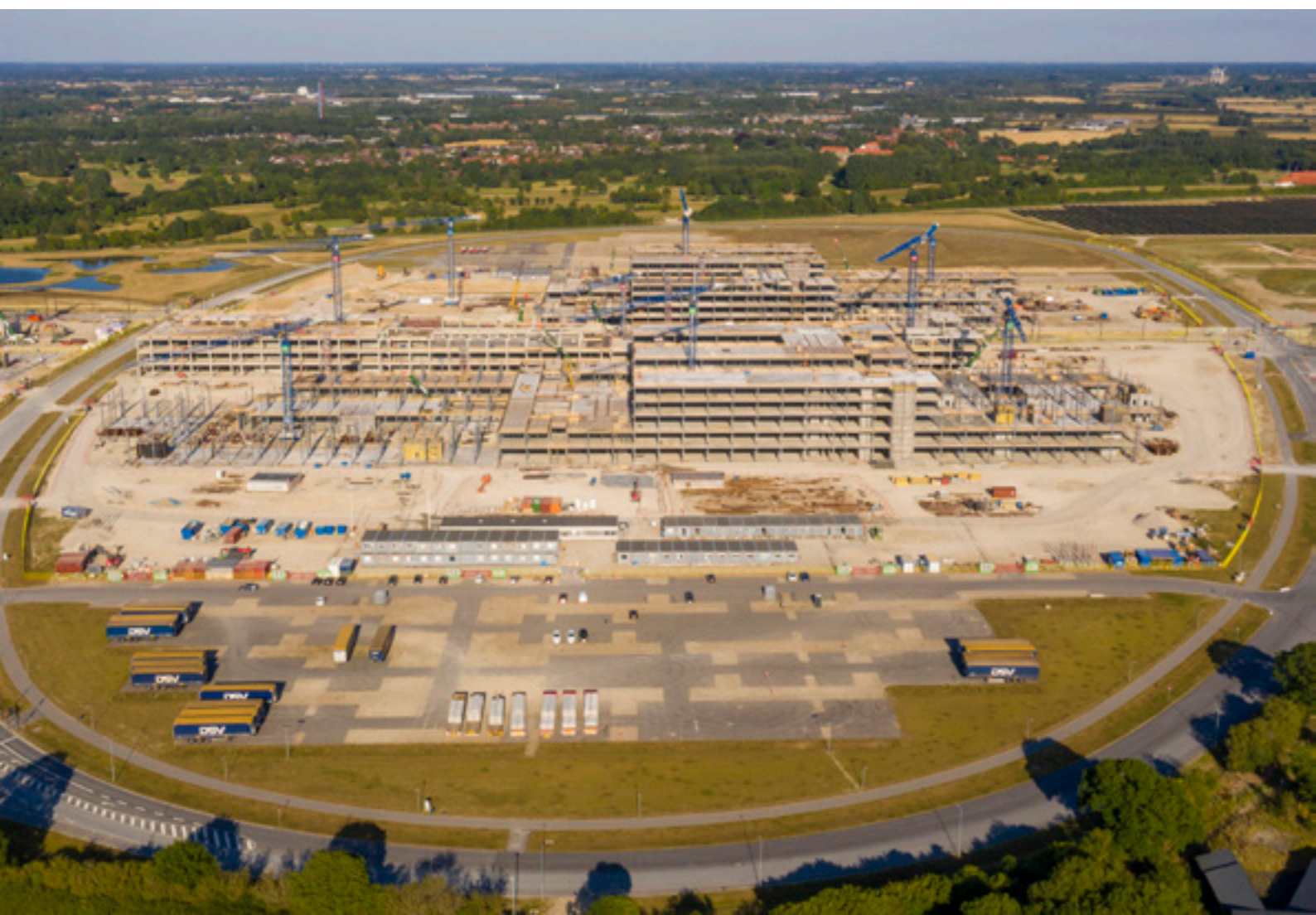
6.500 m Träger NPS® BASIC und 2.400 m Stützen PDTI® NPS®
