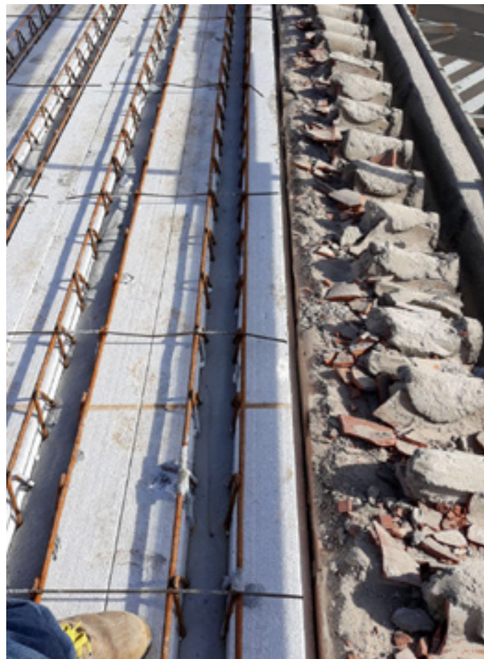
Dank seiner Leichtigkeit ist Airfloor™ ideal für Renovierungen oder Aufstockungen und kann auch mit bereits bestehendem Mauerwerk kombiniert werden.
