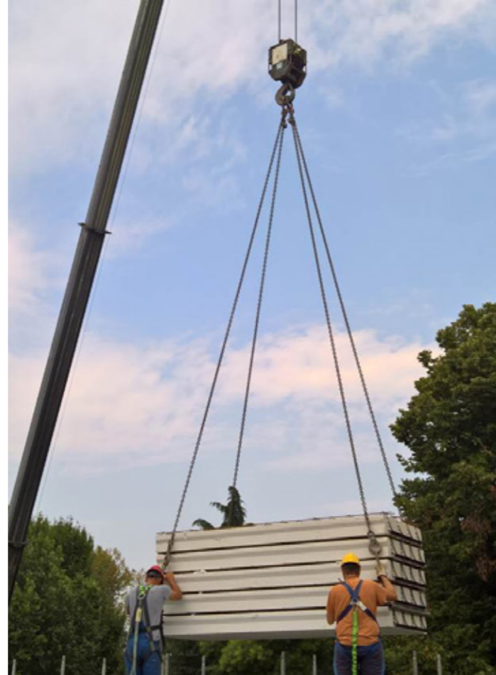
La légèreté d'Airfloor™ permet de soulever plusieurs panneaux en même temps, en accélérant les opérations de manutention.
