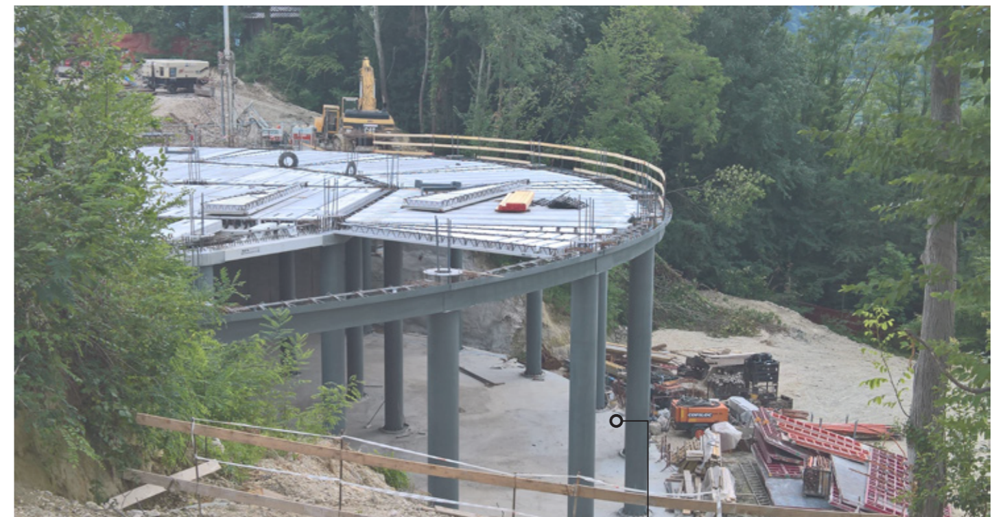
Le projet prévoyait des portées et une hauteur entre niveaux allant jusqu'à 10 mètres, le tout réalisé avec des éléments NPS® dans un seul tronç.
