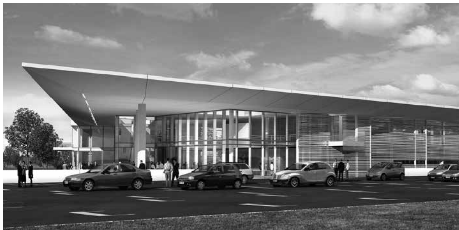
Figura 4: render del nuovo Centro Ricerca e Innovazione di Italcementi, i.lab. Anche grazie alle potenzialità applicative delle Travi REP® nella realizzazione della complessa copertura in cemento biancoTX® Active, l'i.lab di Italcementi prosegue il proprio cammino per diventare il primo "green building" italiano certificato LEED platino
