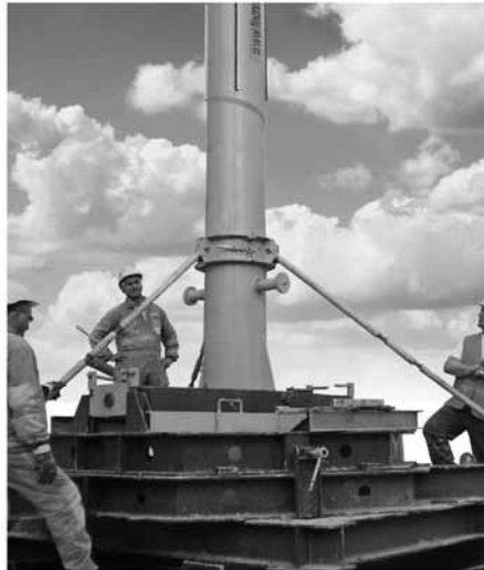
Figura 35: Sistema Zenith per il centraggio dei pilastri
