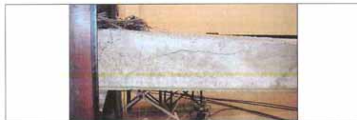
Fig. 23. Quadro fessurativo in corrispondenza dell'appoggio centrale. Campata sinistra, Lato b).
