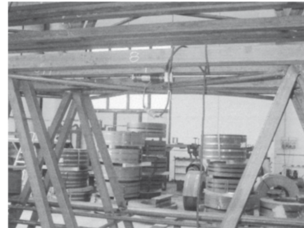
Foto 07 : Sensore di tensione (Ch.8) sul corrente superiore in mezzeria.
