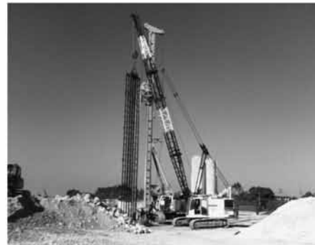
Figura 32: movimentazione ed inserimento REP® Dia
