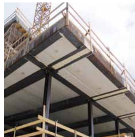
A sinistra: particolare di travi a sbalzo per una lunghezza di 8 metri. A destra: vista d'insieme della maglia strutturale.
