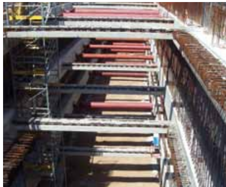
A sinistra: travi-puntone per la realizzazione di una stazione in profondità della linea C della metropolitana di Roma. A destra: dettaglio del sistema costruttivo Top Down REP®.
