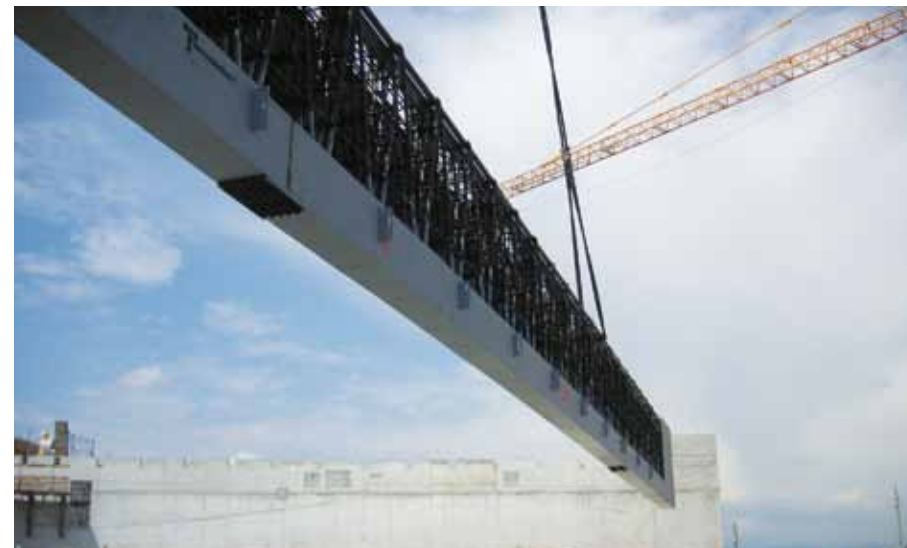
Varo della trave REP® a copertura della sala principale del Teatro di Vicenza. Una struttura lunga 55 metri e alta 3.
