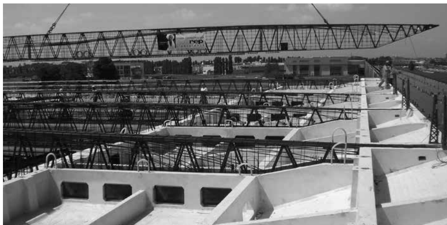
Figura 5: montaggio di Travi REP® Tr per sbalzi da 10 a 18 metri
