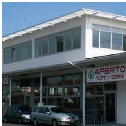
Travi REP® Cls abbinata a pilastri metallici PDTI® e solaio alveolare. Strutture autoportanti per massimizzare la velocità esecutiva. A sinistra, vista dell'edificio finito. A destra: esempio di appoggio trave-pilastro.
