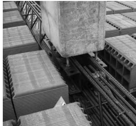
Figura 27: nodo al Pilastro BASIC® con armatura integrativa
