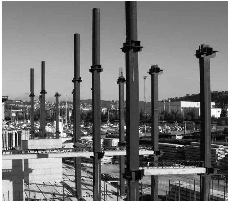
Figura 19: realizzazione con Pilastri PDTI®
