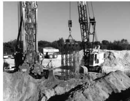
Figura 33: posizionamento REP® Dia
