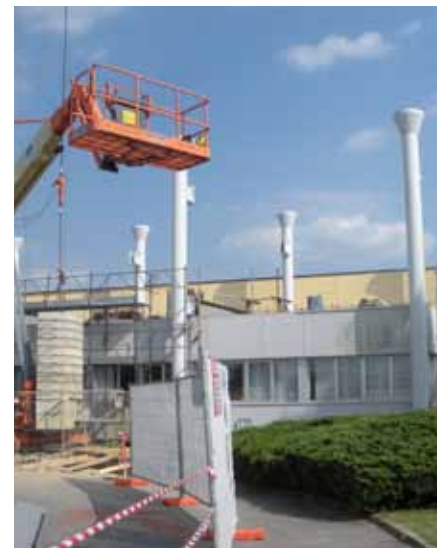
Grazie alle sezioni ridotte, i Pilastri PDTI®, si collocano tra i due edifici esistenti consentendo così di realizzare la sopraelevazione senza gravare sull'impalcato esistente.
