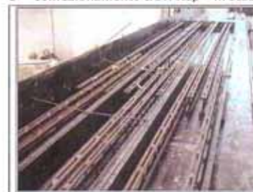
Fig. 6. Posizionamento dei tralicci prima del getto
