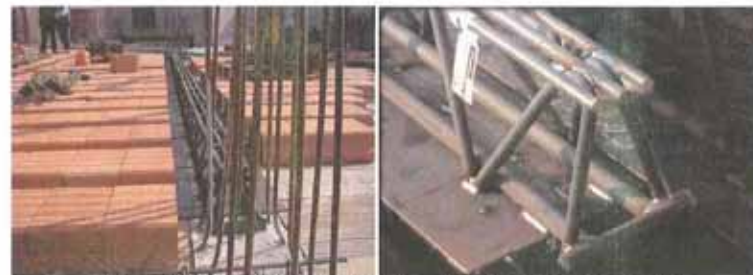
Figura 1: utilizzo di trave REP ® per il sostegno di un soletto e dettaglio della sezione terminale
