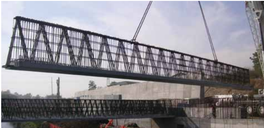
Per la realizzazione del solettone della galleria artificiale sono state utilizzate 211 Travi Rep® Cls da 24 m ciascuna e 2.200 tonnellate di acciaio lavorato. 12 in tutto i giorni di posa.
