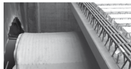
Figura 3: applicazione delle Travi REP® Cls
