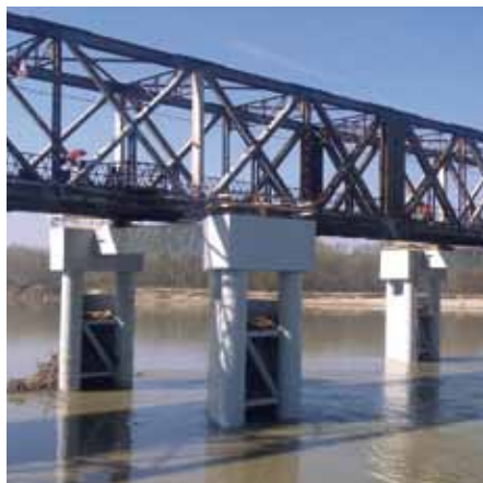
A sinistra: due pulvini REP® per il sostegno del ponte. A destra: operai seguono il montaggio della struttura.
