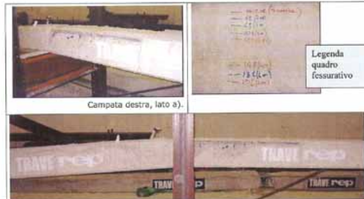
Fig. 20. Quadro fessurativo nella zona di appoggio centrale all'aumentare del carico.
