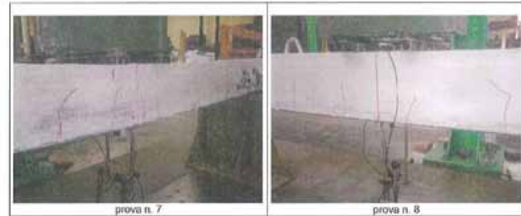
Figura 15: mappa delle fessurazioni nelle travi miste al termine della prova di rottura per flessione
