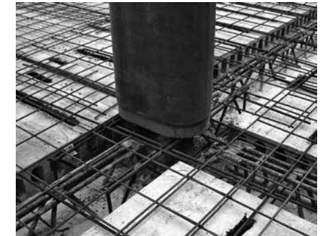
Figura 23: nodo al Pilastro PTC® con armatura integrativa
