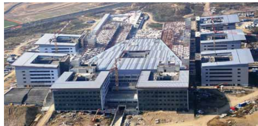
Panoramica degli edifici dedicati alle degenze e della piastra sanitaria. L'intera maglia strutturale è realizzata con Pilastrini PDTI® e Travi REP®.
