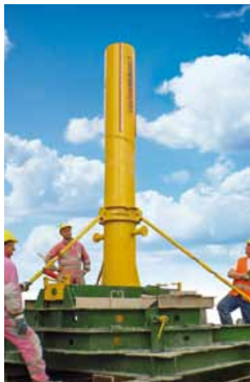
A sinistra: il sistema Zenith, ideato da Tecnostrutture per il centraccio ottimale dei pilastri. A destra: vista dei pilastri infissi nel sottosuolo.
