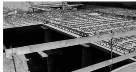
Figura 14: montaggio delle Lastre REP®
