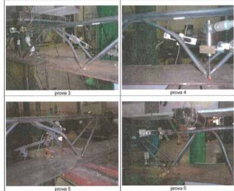
Figura 13: dettaglio delle diverse modalità di rottura nelle prove a taglio su traliccio nudo
