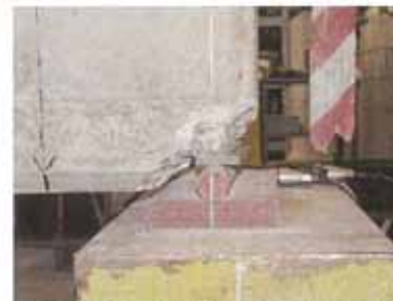
Foto 3: particolare appoggio sul martello
