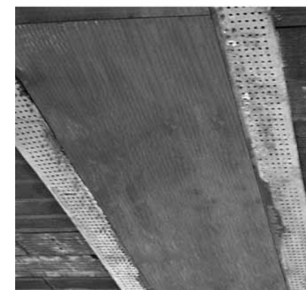
Figura 18: abbinamento ECOTRAVE® e solaio in latero-cemento
