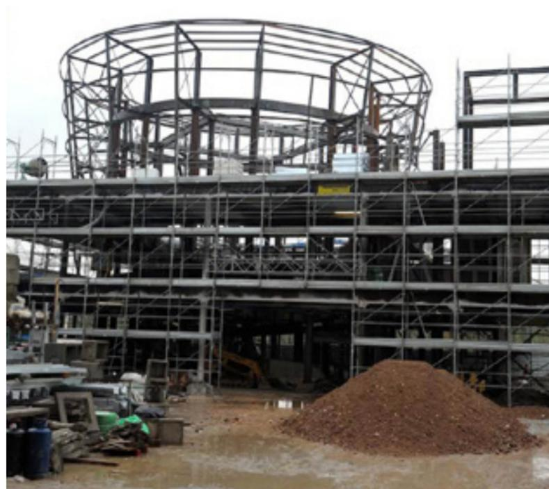
Tecnostrutture ha fornito 1400 metri di travi Basic NPS® e 1000 metri di pilastri PDTI® oltre alla fornitura e al montaggio di strutture metalliche per la realizzazione del **corpo conico centrale avente diametro di 11 metri e altezza di 8 metri**. Questa struttura caratterizza il padiglione, ergendosi come una cesta gigante al cui interno è previsto un percorso espositivo elicoidale.
