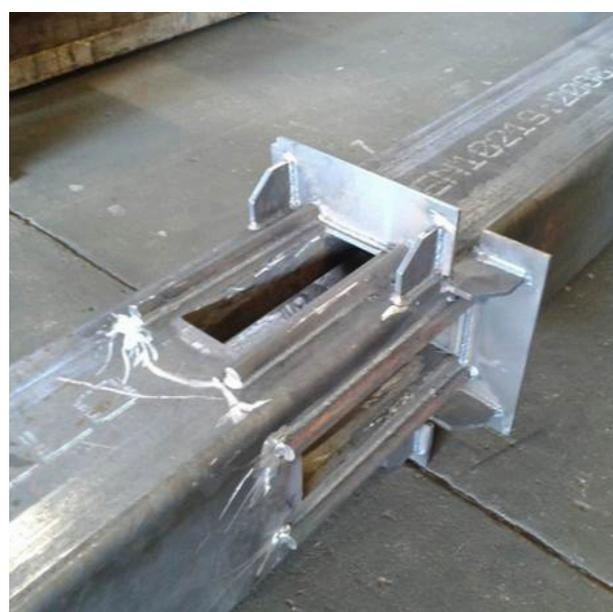
La forme particulière du nœud poteaux-poutre que on viens de décrire, la nécessité de réaliser des éléments de dimensions et de poids limités et les épaisseurs réduites pour la construction de planchers ont mis en évidence la nécessité de réaliser des éléments de poteaux de longueur inférieure à la hauteur libre entre les étages, avec des jonctions positionnés différemment en rapport au standard normalement utilisé.
