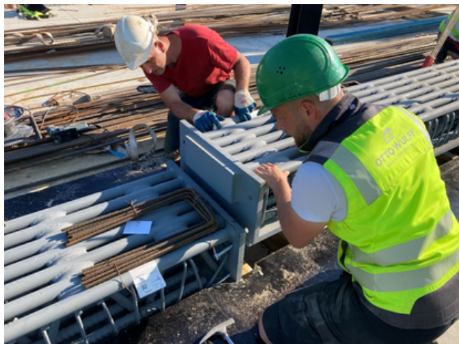
Detail des Baustellenanschlusses
